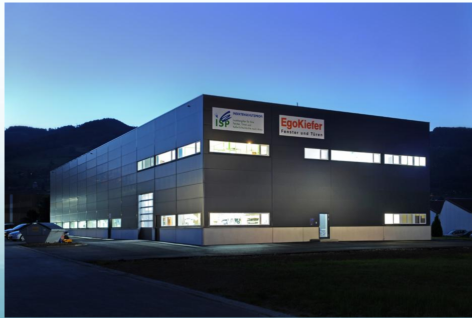
Usine Altstätten Baffles
